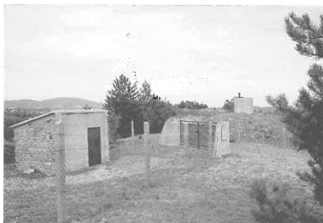
Captage du Serre à St-Priest
