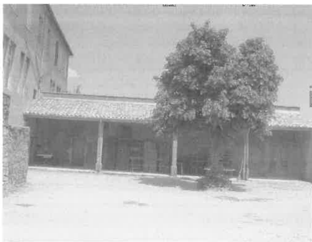
Le préau de l'ancienne école pendant et après les travaux de restauration.
